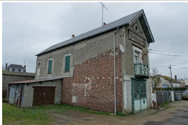
*Rue Boucault : enduit ciment posé sur des maçonneries en briques*
