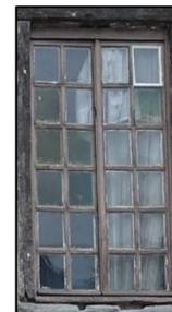
Sont à proscrire : le remplacement des menuiseries anciennes par de nouvelles menuiseries standardisées non conformes aux modèles anciens, la pose dite « en rénovation » (pose d'un nouveau châssis sur le dormant laissé en place de la fenêtre d'origine), l'utilisation de matériaux autres que le bois (PVC, aluminium), ainsi que l'ajout de petits bois « dans le verre ».
