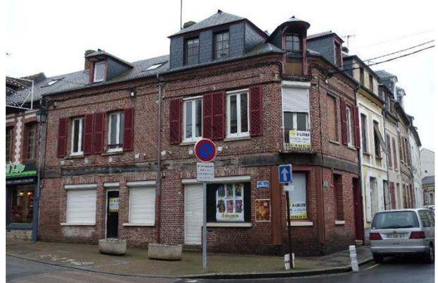
*33-35 rue des bouchers : le rez-de-chaussée a été largement remanié avec de larges ouvertures qui ne correspondent pas aux rythmes des percements de l'étage
