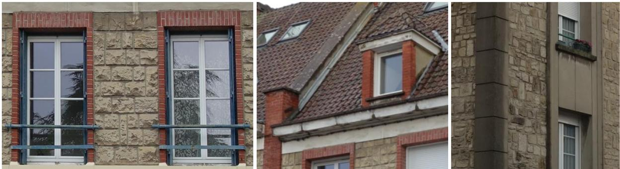
*Quelques éléments intéressants : encadrements des baies en brique, fenêtres, persiennes, pignons débordants en brique et béton, lucarne capucine, chaîne d'angle en béton, jambages des baies en béton*
